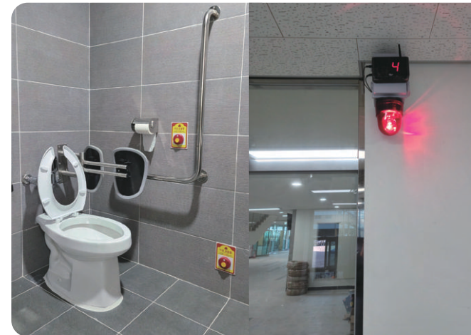
인천 송도 소재 초중고 - 장애인 화장실
